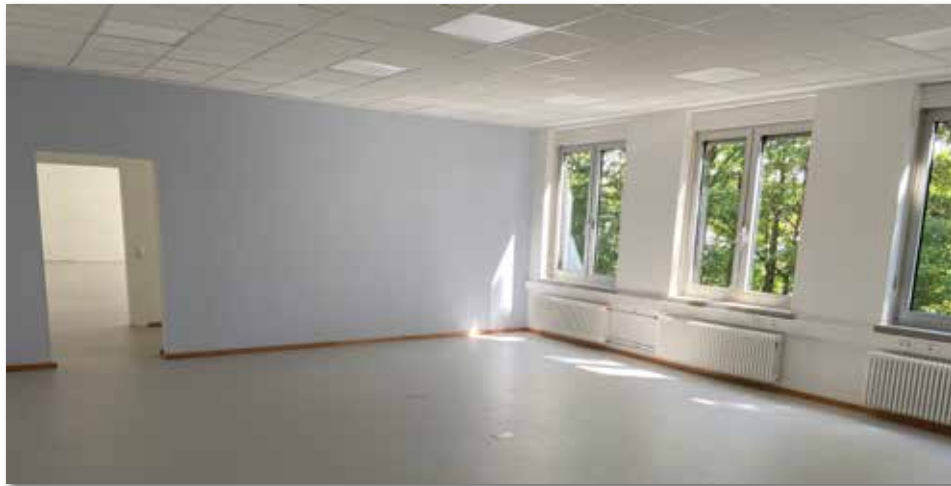
Die Sanierung der Unterrichts- und Seminarräume der Landwirtschaftsschule war Teil der jüngsten Baumaßnahme.
