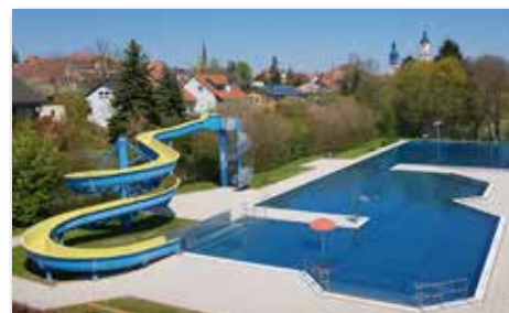
Das Freibad in Uffenheim punktet unter anderem mit einer 50-Meter-Rutsche. Foto: Jürgen Hofmann
