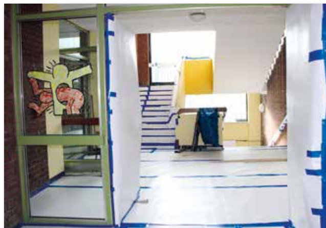
Blick in das mit Folien gut verpackte Treppenhaus
