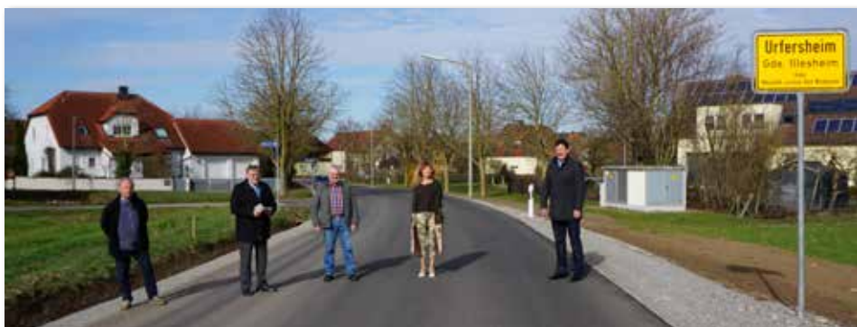
Illesheims Bürgermeister Roland Scheibenberger, Veronika Johnson als Vertreterin der amerikanischen Streitkräfte, der frühere Bürgermeister Heinrich Förster, Landrat Helmut Weiß und Peter Holzmann von der Tiefbauverwaltung machen sich ein Bild von dem sanierten Streckenabschnitt.
