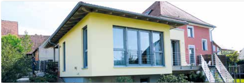
Wohnhaus, ergänzt durch modernem Anbau, der Familie Schenke.
