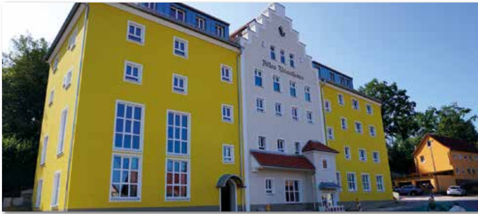
Das Alte Brauhaus Emskirchen erstrahlt nach umfassender Sanierung in neuem Glanz.
