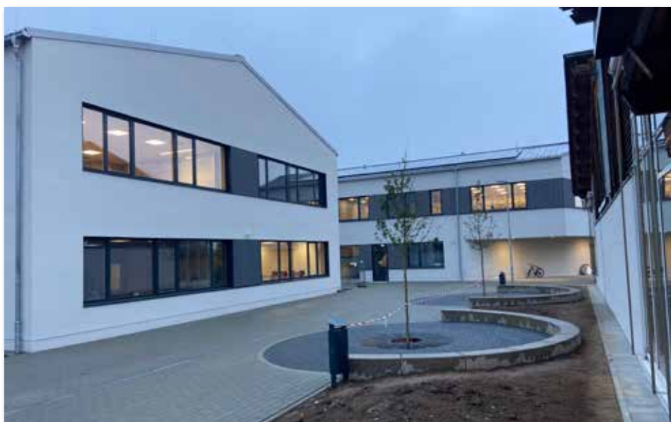
Der Neubau des Gymnasiums in Scheinfeld schreitet voran, bis 2023 ist die Fertigstellung der Maßnahme geplant.
